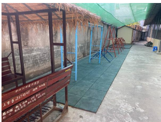
鉄棒場の安全マット敷設 【施工業者 KDRAGON PRODUCTS & ENGINNRING CO.LTD】
